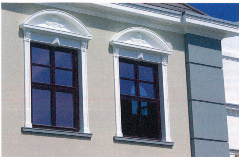
4 Die Stuckateure setzten zwar auch selbst vorgefertigte Elemente ein. Einen Großteil der Stuckarbeiten führten sie aber direkt vor Ort aus. (Fotos 2 + 4: Tubag)
